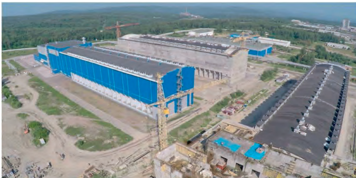
Рис. 3 – Общий вид строящегося комплекса централизованного «сухого» хранения ОЯТ
