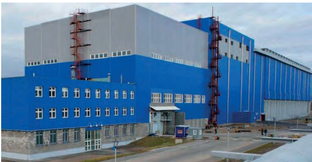
Рис. 2 – Общий вид первого пускового комплекса «сухого» хранилища ОЯТ
