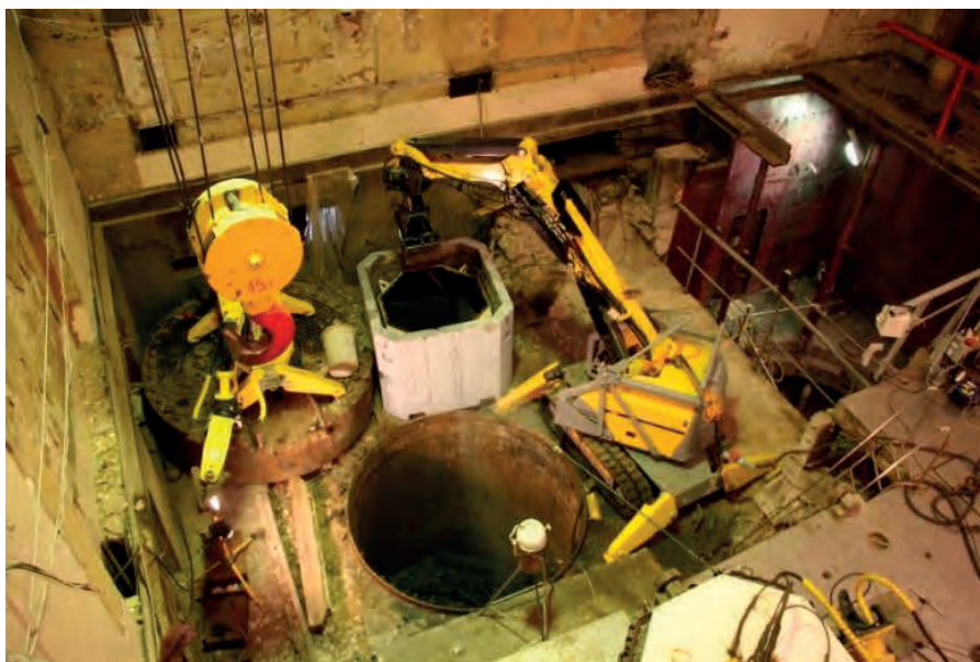
Рис. 8 – Внешний вид шахты реактора РФТ и бассейна реактора МР после демонтажа внутрикорпусных конструкций
